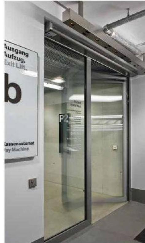
Bezbariérový přístup do sanitárního prostoru je zajištěn pohonem DORMA CS 80 Magneo a ovládán bezdotykovým ovladačem MagicSwitch.
