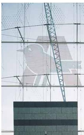
Durchdacht: Auf den Obergurten der Windträger sind Waagbalken aus Flacheisen aufgeschweißt, an deren Ende die RODAN Glasklemmhalter befestigt sind.
