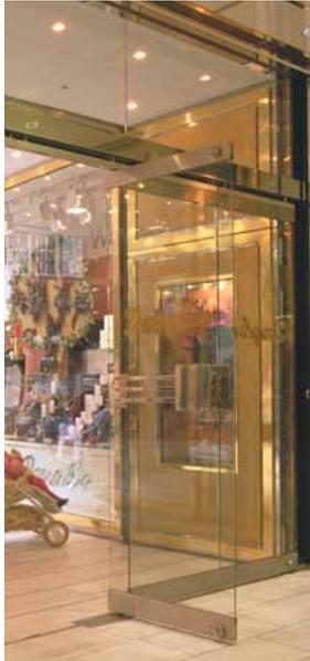
Bei einer HSW-G Anlage können die einzelnen Flügel mit bestimmten Funktionen ausgestattet sein: vom einfachen Schiebeflügel über integrierte Türen mit unterschiedlichen Türschließern bis hin zu Sonderflügeln für spezielle Einbausituationen. Jede Anlage kann nach Ihren Wünschen und Vorgaben konfiguriert werden.
